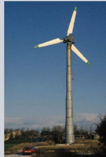
Annelise Laursen har vært ansatt hos Bonus/Siemens i 28 år. Nacellen på 30 kW-mallen som er vist her veier kun 1,645 kg. Til sammenligning veier 3,6 MW nacellen 125 tons.
